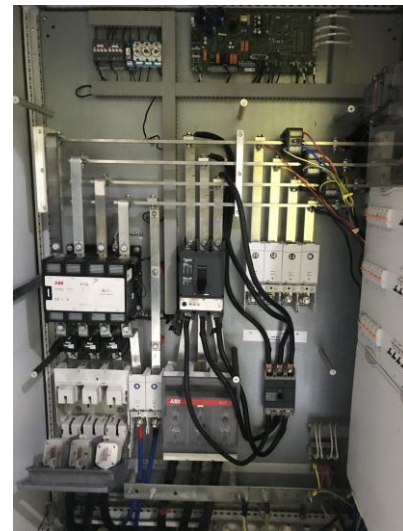
Fig 6. 300 kW Multicluster Box
